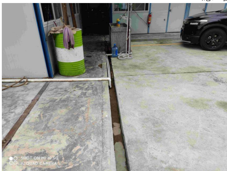
施工营造区排水沟
