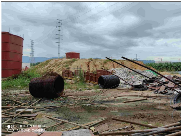
项目临时堆土区
