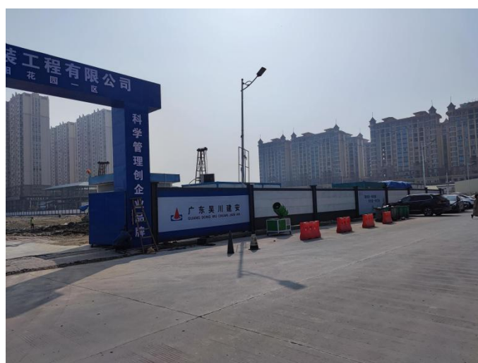
西侧已建市政道路
