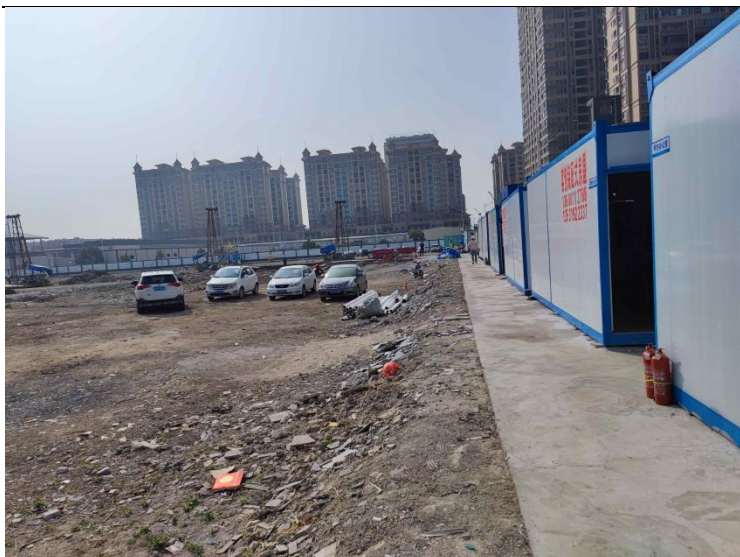
西侧施工营造区
