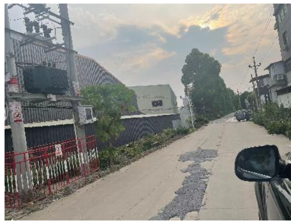
项目北侧 厂房
