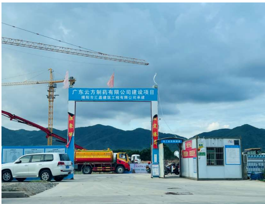
宝山西路南侧用地在建工地
