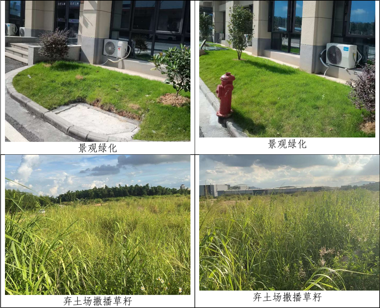
图 4-1 工程措施、植物措施现场照片
