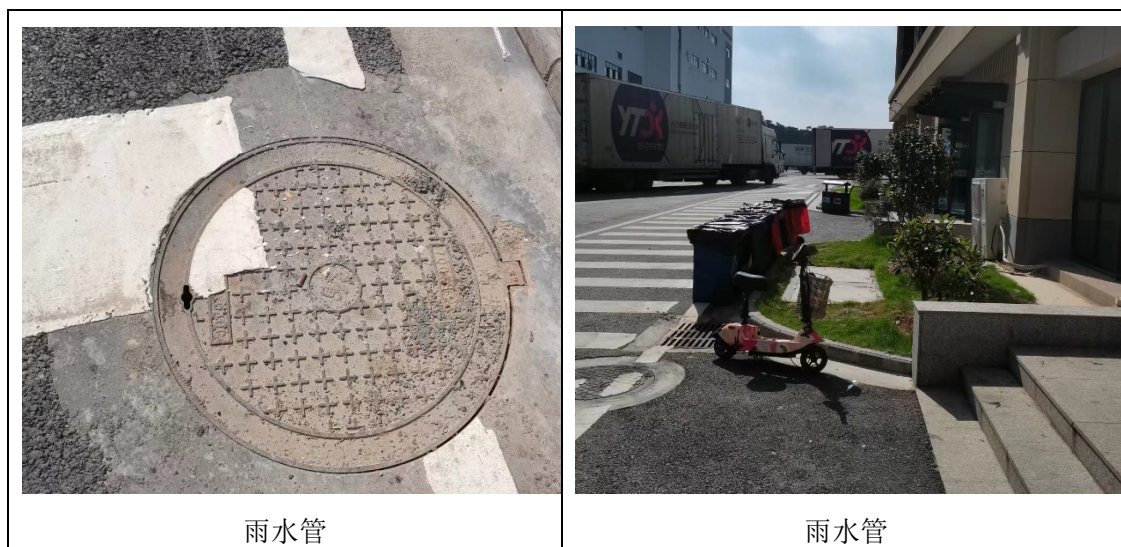
图 4-1 工程措施现场照片
