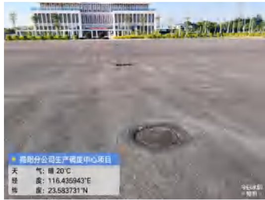
预留用地区地面硬化、雨水管网已实施
