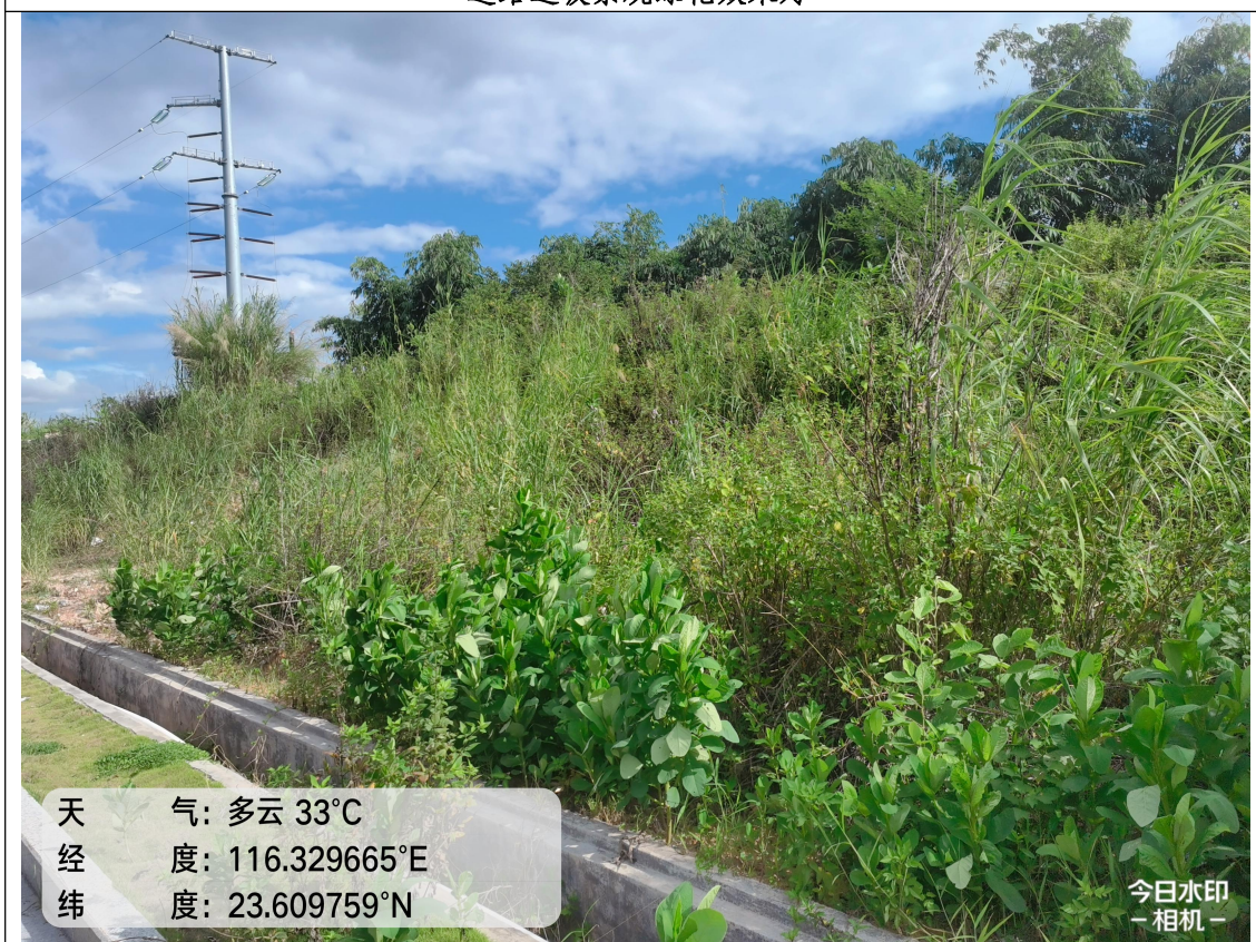
道路景观绿化及路边排水明沟
