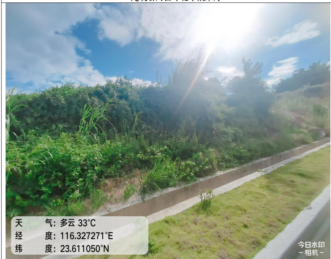
道路绿化及排水明沟
