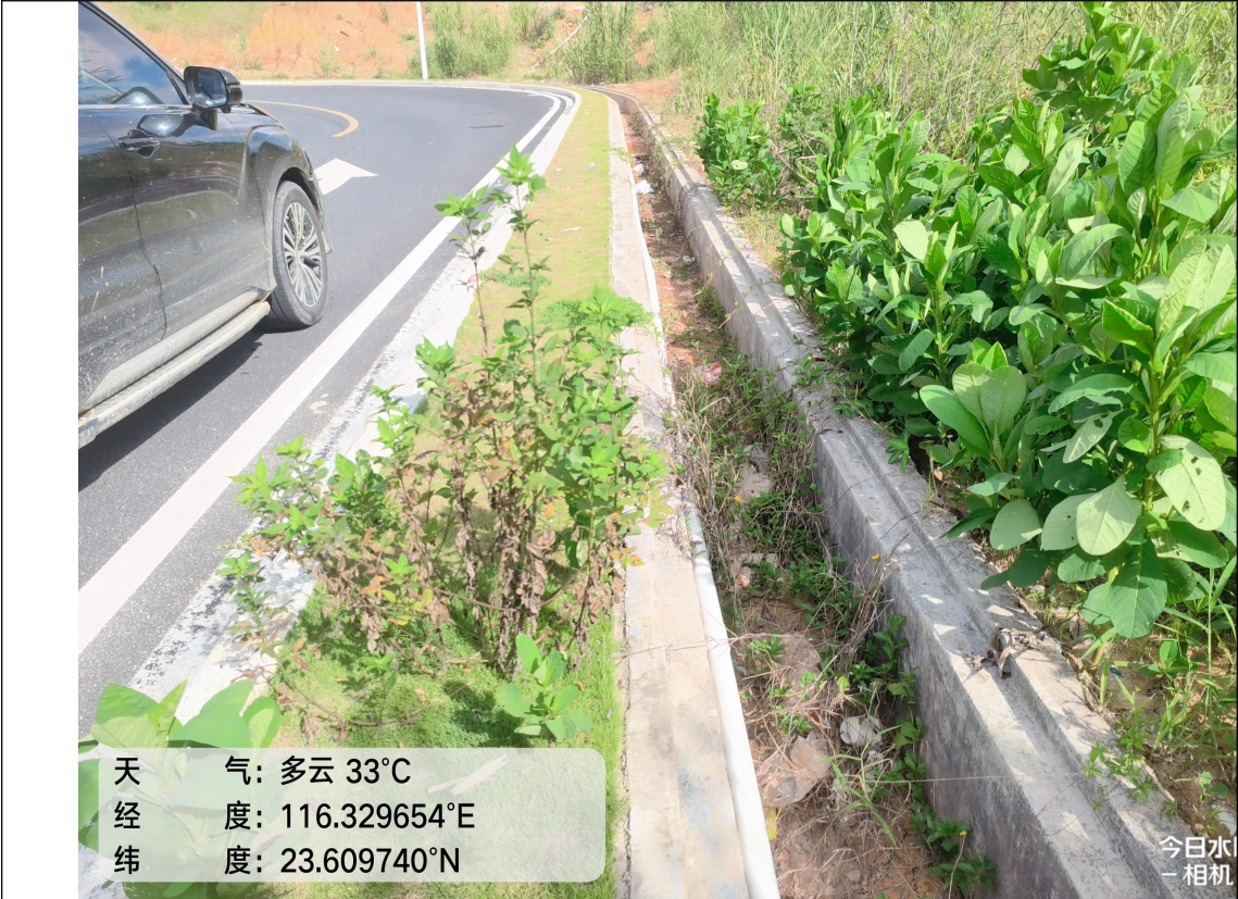
道路排水沟结构完好，排水效果好，边坡绿化防护效果好；
