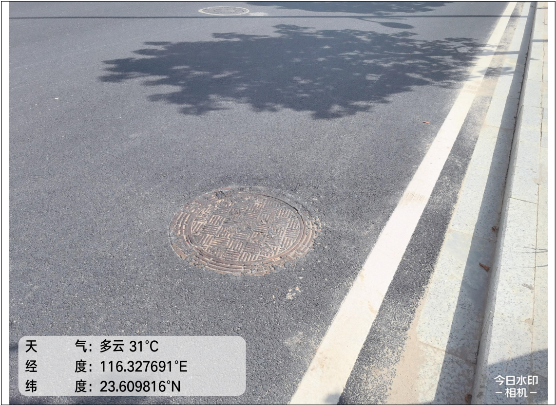
地面已硬化、沉沙井结构完好
