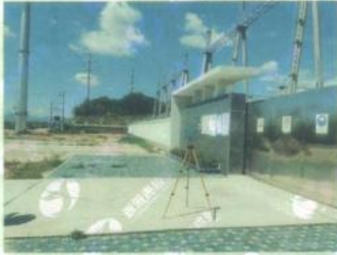
变电站东侧电磁场监测
