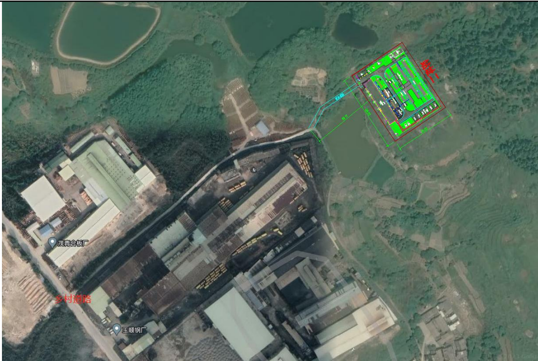
图 2.5-3 站址二现场照片
