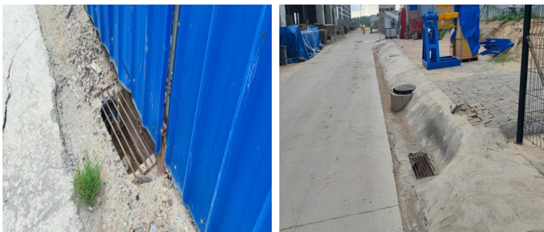
主体工程区排水措施
