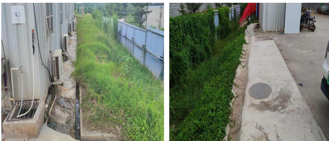
施工营造区临时排水措施
