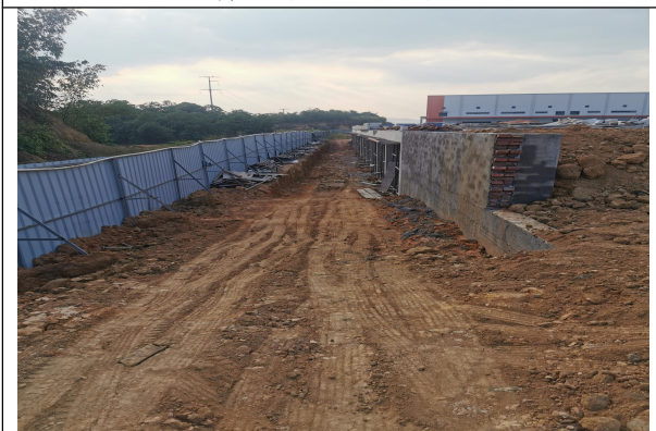
主体工程区外侧道路
