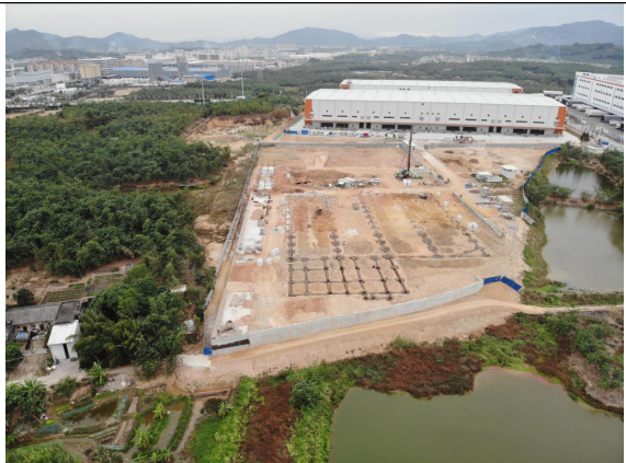
主体工程区（东侧）
