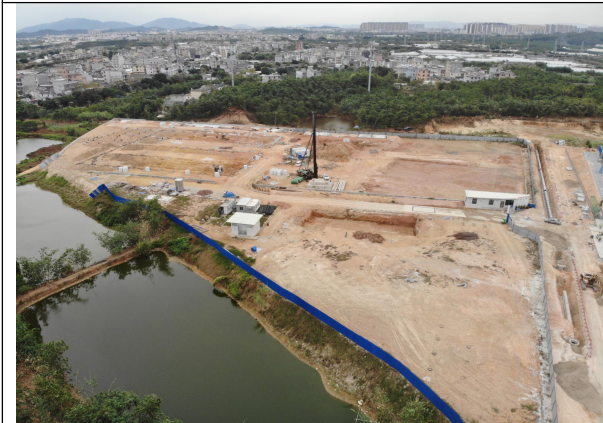
主体工程区（北侧）
