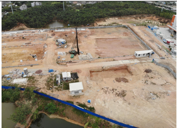
主体工程区（北侧）
