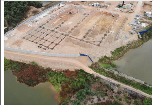
主体工程区（东侧）
