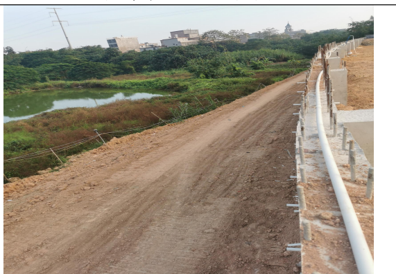
主体工程区外侧道路
