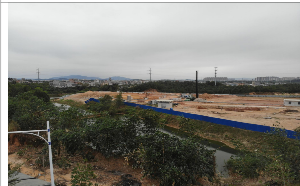
主体工程区（北侧）
