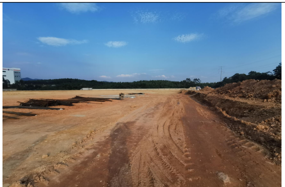
临时堆土区（右侧）
