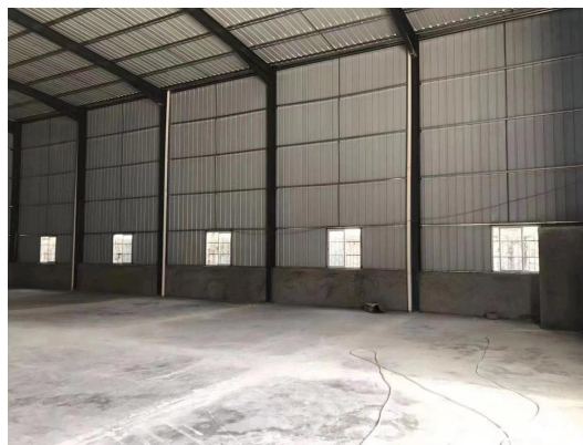
生产车间 2 现状
