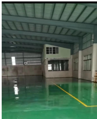
生产车间 1 现状
