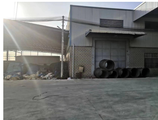
生产车间 1 西面厂房
