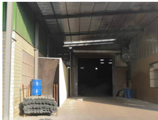
生产车间 1 南面、生产车间 2 北面厂房
