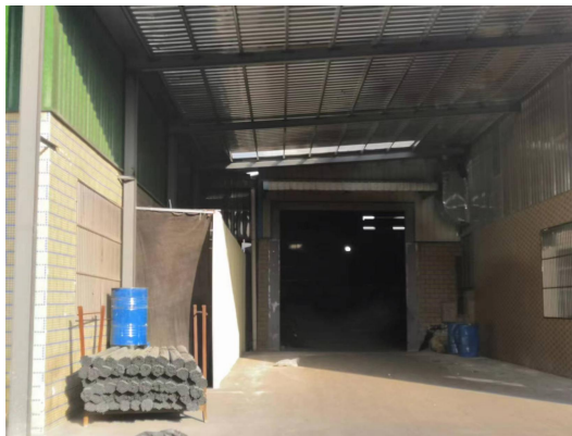
生产车间 1 南面、生产车间 2 北面厂房
