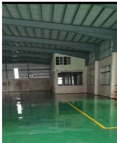
生产车间 1 现状
