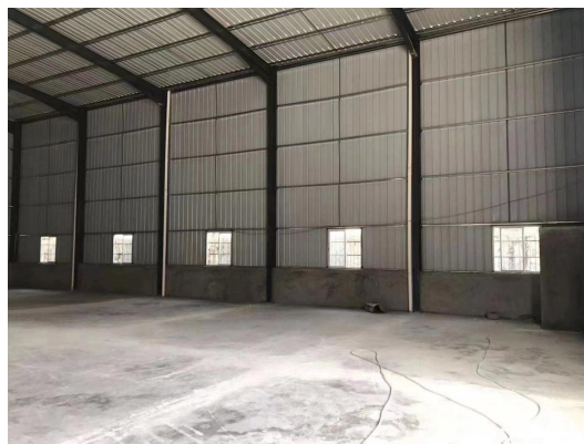
生产车间 2 现状
