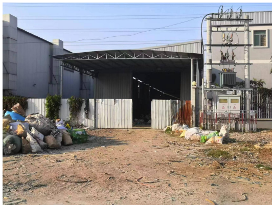
生产车间 1 东面厂房
