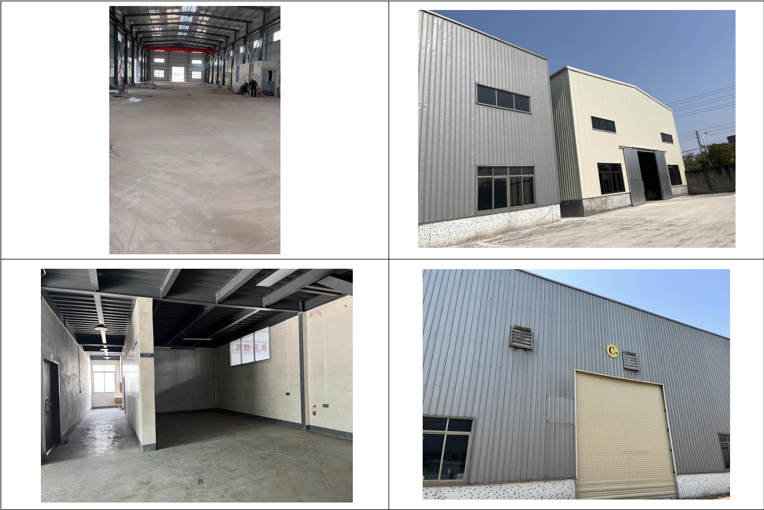
附图六 项目现状及硬底化照片图
