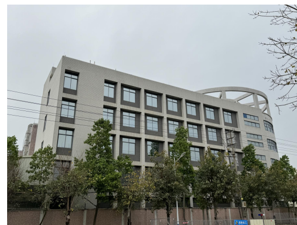
项目西北侧 厂房
