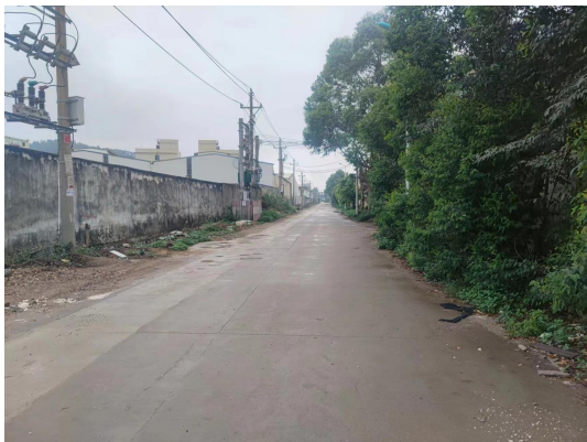
项目北侧 道路
