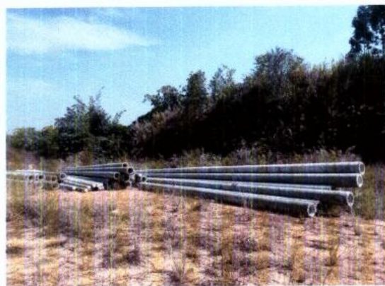
项目道路中段—建筑材料堆放点
