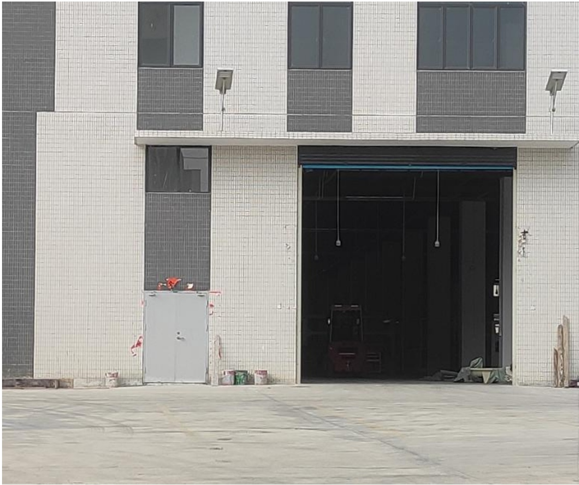
项目厂区及车间地面硬底化照片
