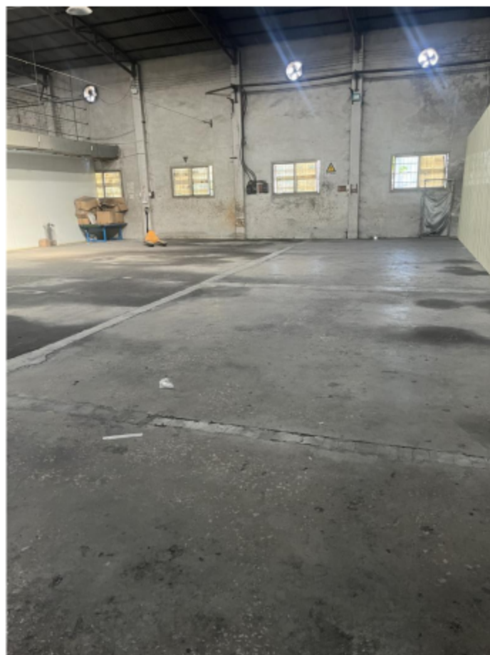
附图五 项目现状及硬底化照片图
