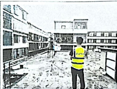
西北面居民点 (GD) (E: 116° 25'43", N: 23° 34'7")
