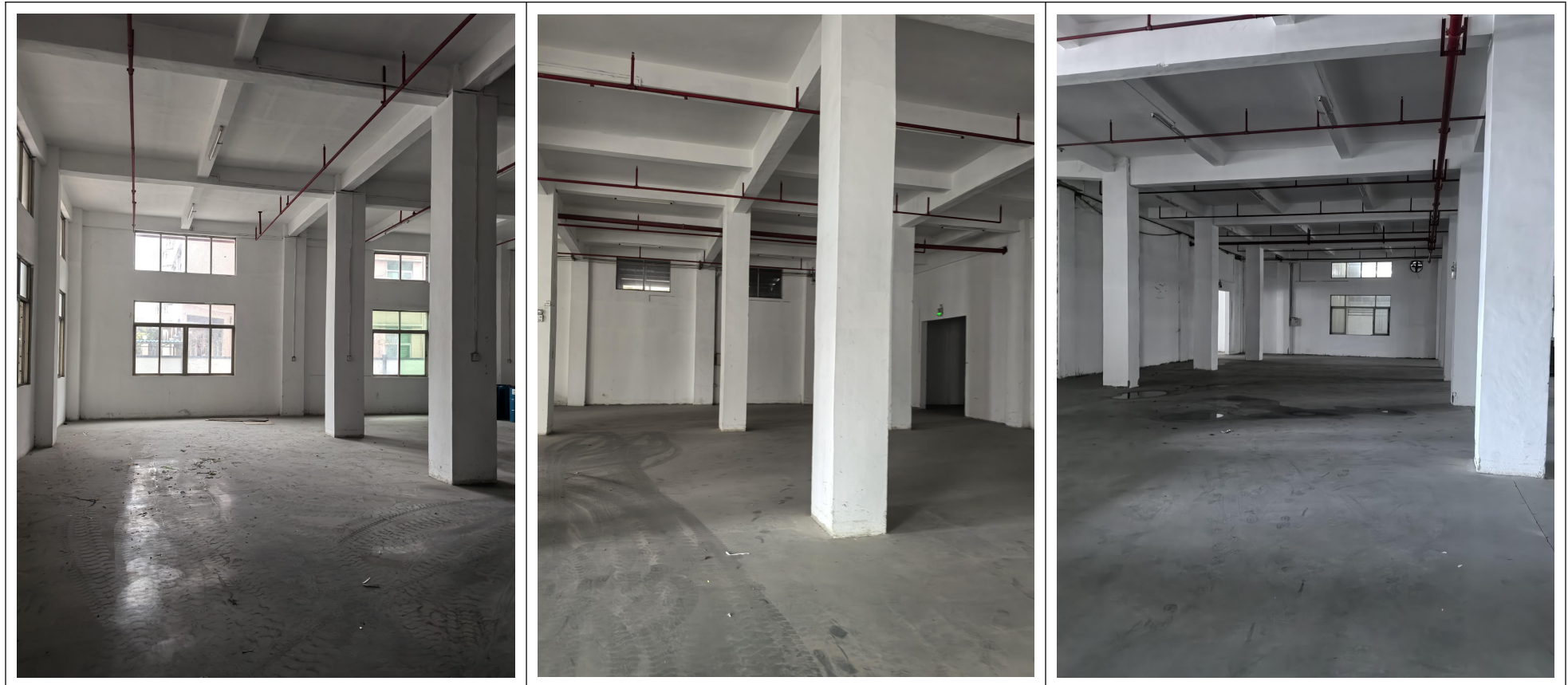
项目厂房现状
