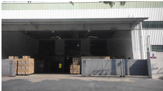
项目东北面（海兴新厂）
