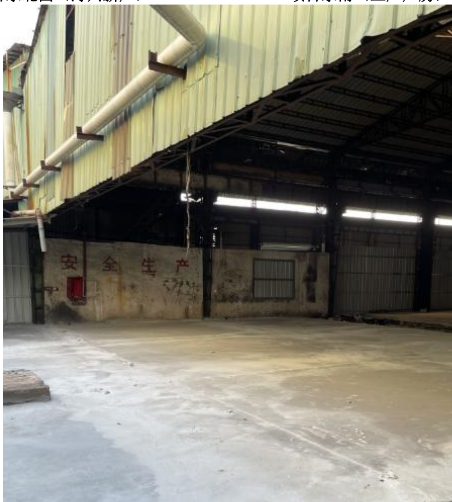
地面硬底化照片项目
