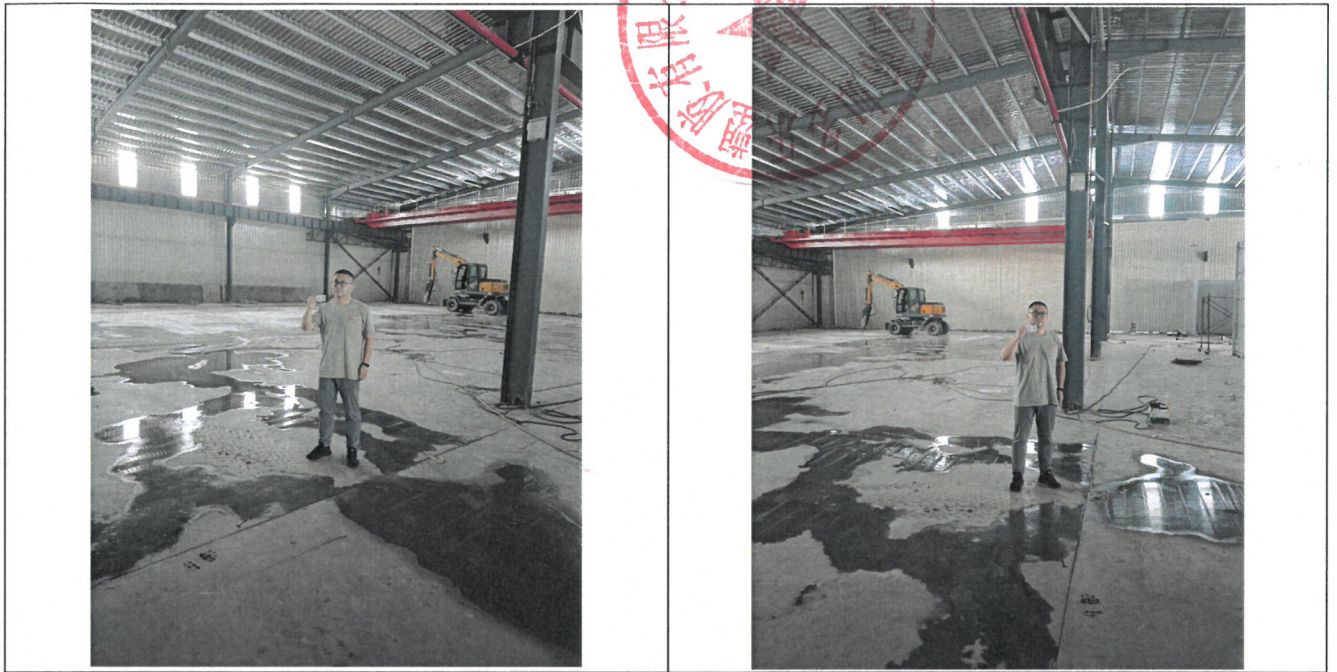
附图 11 项目四至和工程师现场勘查照
