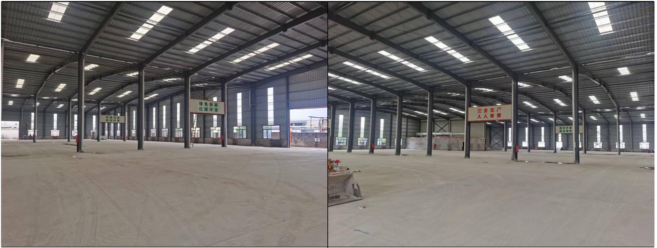
项目厂房（汽车拆解车间）
