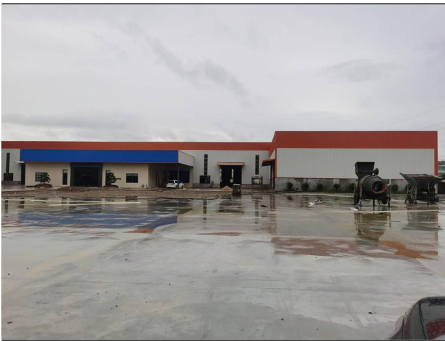
项目厂房（汽车拆解车间）
