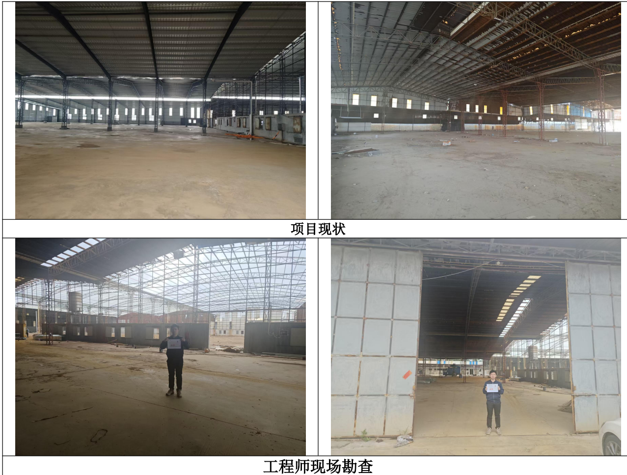
附图六 项目现状及工程师勘查现场图
