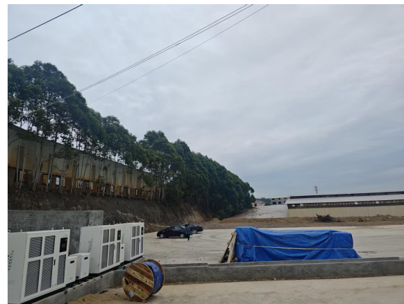
项目南侧 在建厂房
