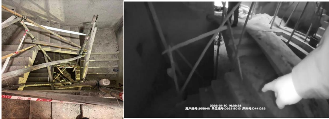
图1 事故现场情况
