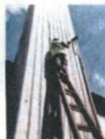
抛光车间1排气筒 (DA001) 处理后
