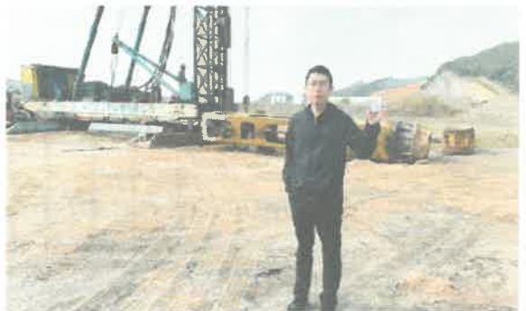
工程师踏勘现场照片 2
