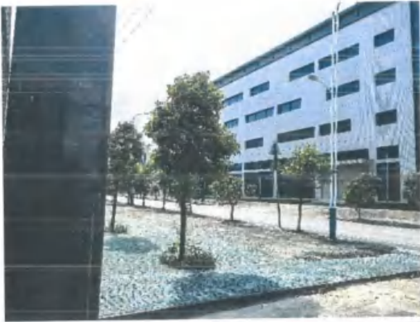
项目北侧智水街和其他厂房
