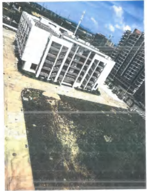
项目南侧园区空地和厂房
