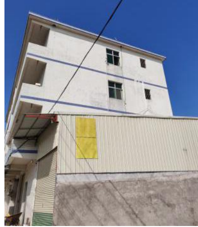
项目西侧 厂房
