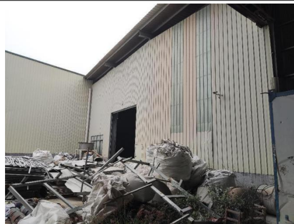
项目南侧厂房
