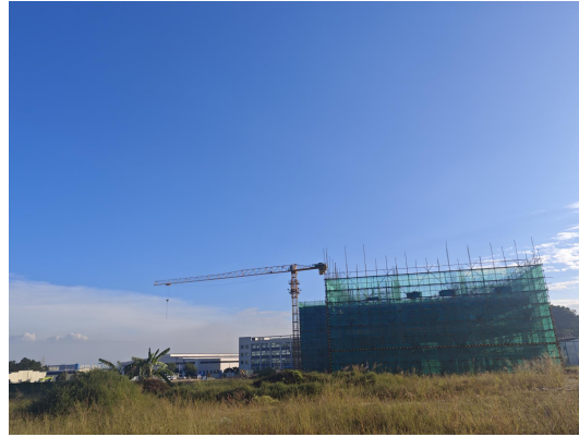
1#地块南面在建厂房
