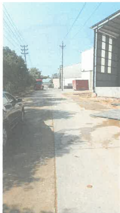
南侧园区道路
